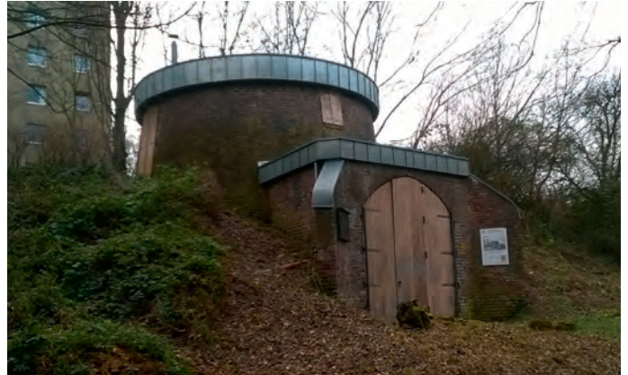
Der historische Mühlenstumpf an der Straße „An der Rheindorfer Burg“ beherbergt heute das Pfadfinderheim.
