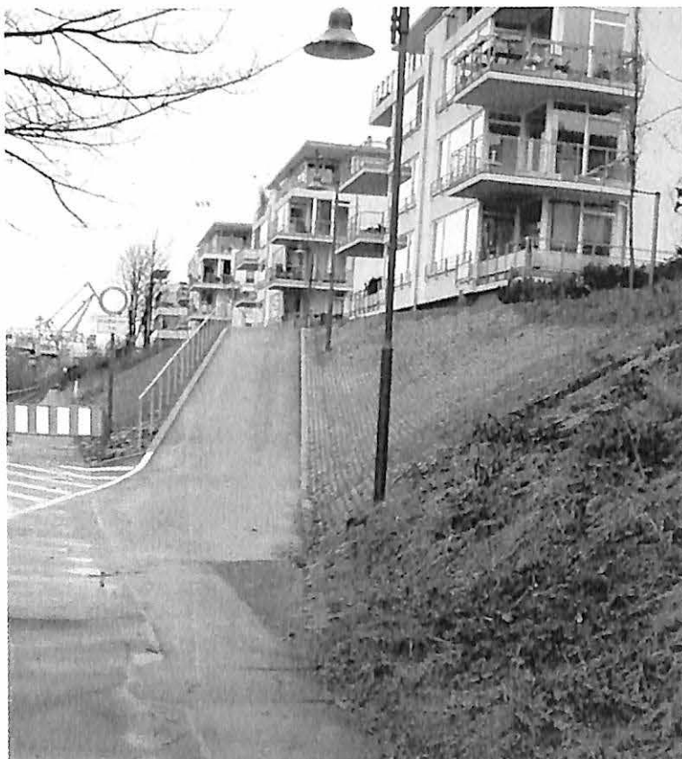
Zur Nutzung freigegeben: Oberer Hangweg fertiggestellt
